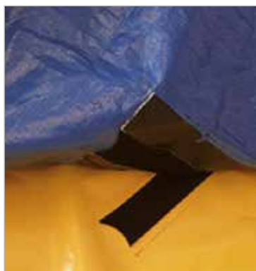
Particolare del fissaggio tra vasca e liner.
