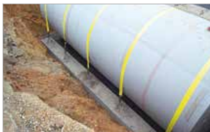
Lavaggi di serbatoi interrati
