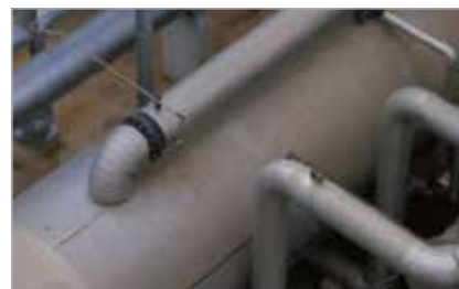
Lavaggi impianti di raffinazione
